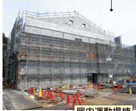
屋内運動場棟
