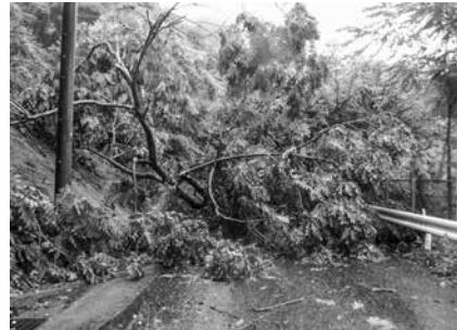
大雨による土砂崩れ（町道7号線）
