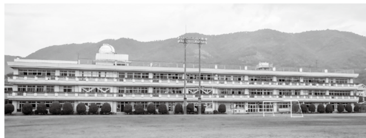
大規模改修予定の松田中学校校舎
