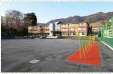
グラウンドに遊具を設置しました。
