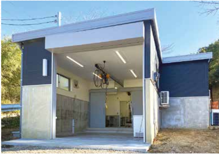
施設概要 所在地：松田町松田庶子1213番地1 構造：木造一部RC造平屋建て 建築面積：82㎡
