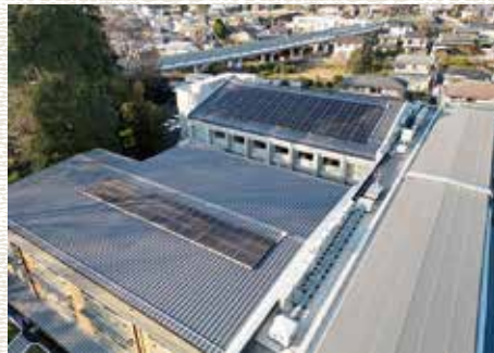
普通教室棟と体育館棟の屋根に設置しています。
