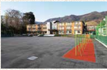
グラウンドに遊具を設置しました。
