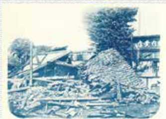
「松田町停車場構内の被害」 出典:『大正震災志寫真帖』
