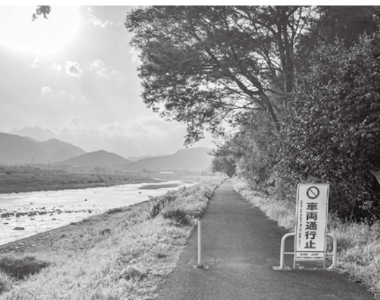
坂本地区の左岸堤防
