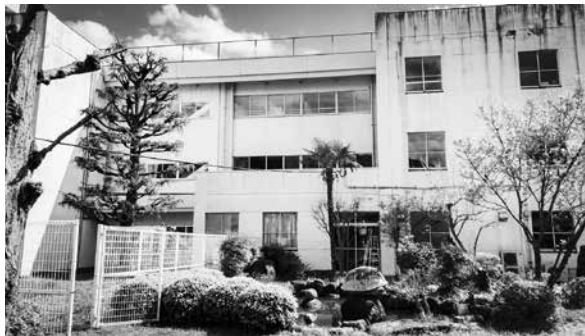
エレベーター設置予定箇所外観
