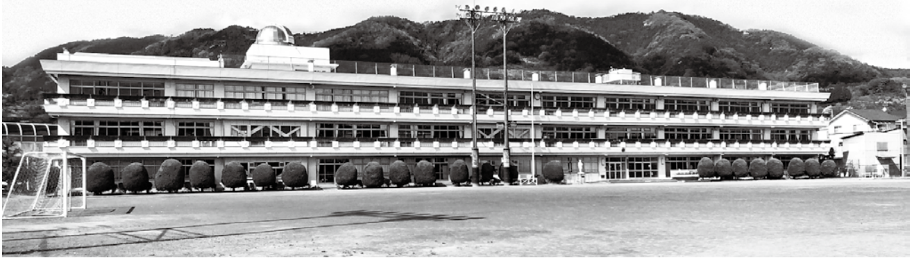
大規模改修工事が予定されている松田中学校校舎
