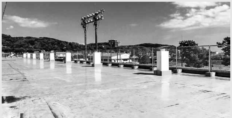
防水工事を予定している屋上
