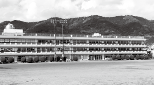
改修工事前の松田中学校
