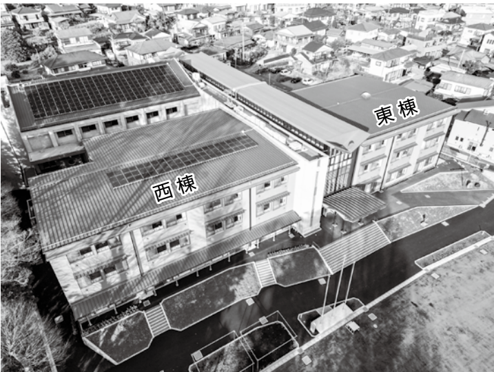
今年度東棟・西棟に太陽光発電設備を設置する松田小学校
