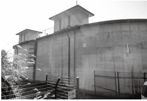
河南沢配水池
