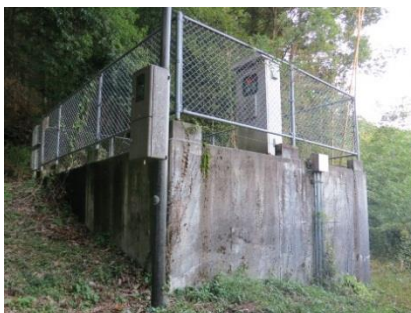
宮地・田代第3配水池
