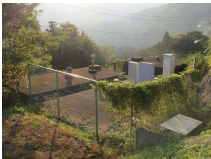
弥勒寺第1, 2, 3配水池
