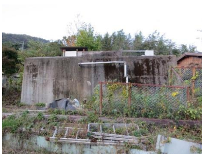
宮地・田代第1配水池
