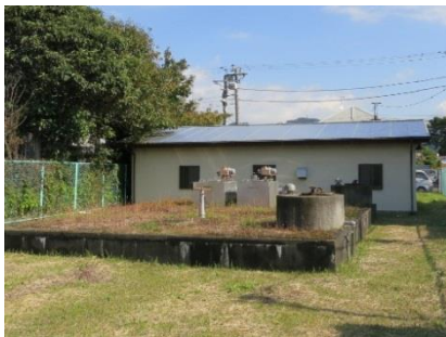
宮下水源施設
