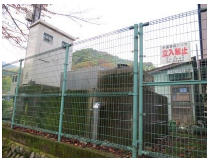
宇津茂送水ポンプ場
