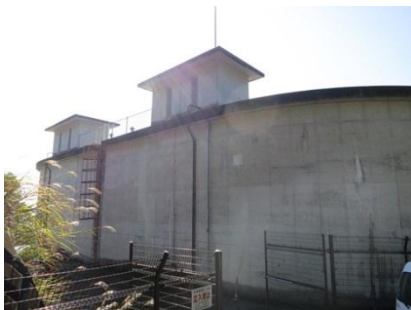
河南沢配水池
