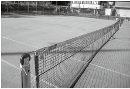
改修工事を行う寄テニスコート
