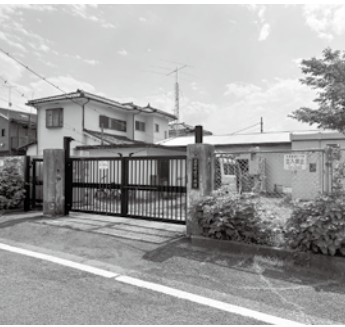
改修工事中の宮下水源
