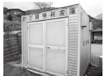
更新予定の防災倉庫
