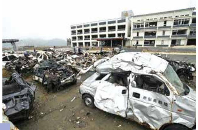
▲被災直後の陸前高田市庁舎前
