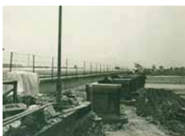
十文字橋改修工事の様子
