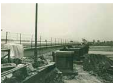
十文字橋改修工事の様子
