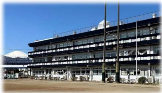
改修後の 松田中学校校舎
