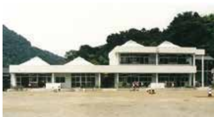
町立第一幼稚園新園舎完成
