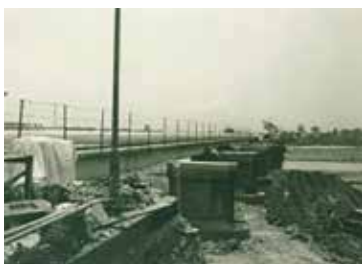
十文字橋改修工事の様子
