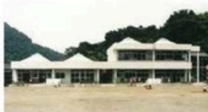
町立第一幼稚園新園舎完成
