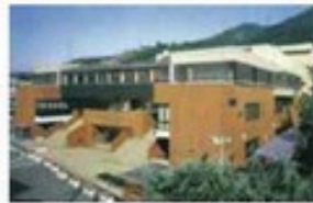
町民文化センターが完成 (現：町生涯学習センター)
