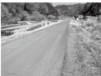
中津川の堤防道路
