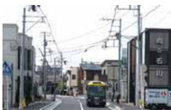
無電柱化の実施前
