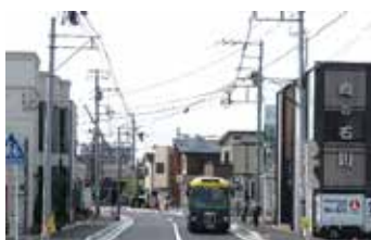
無電柱化の実施前
