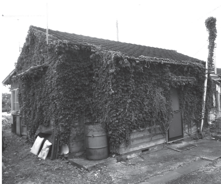
沢尻町営住宅の空き家・H26年度解体予定
