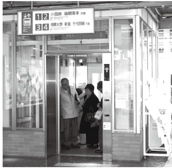
小田急線新松田駅エレベーター (下り線ホーム)
