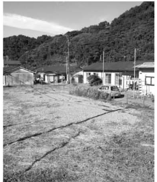
一部解体整地した中河原町営住宅
