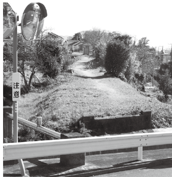
道路整備で利便性向上を(砂利線跡地)
