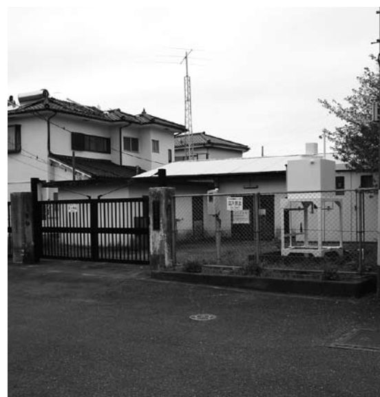
水位計や電動弁を改修する宮下水源地
