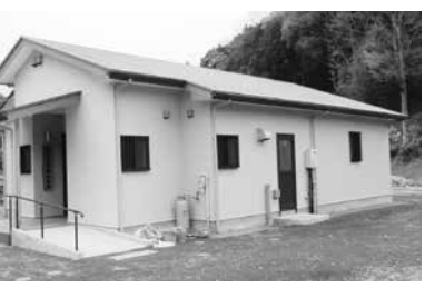
新築された萱沼地域集会施設
