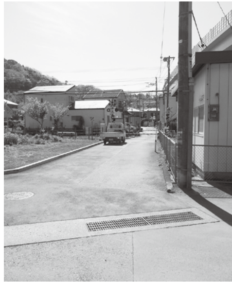
拡幅された町道23号線
