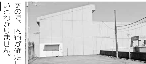
壁にクライミングウォール設置
