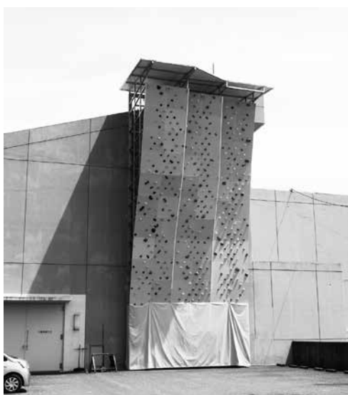
町民文化センター外壁に設置されたリードウォール(高さ13m・幅6m)
