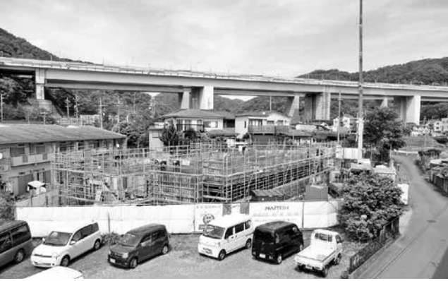
建築中の籠場地区の町営住宅
