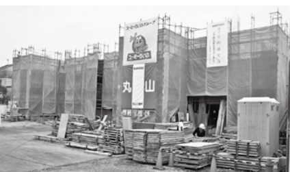
町屋地区に建設中の町営住宅
