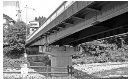
長寿命化計画に基づき橋脚の補強と落橋防止装置が設置された大寺橋
