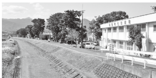
川音川右岸の堤防(町道4号線)
