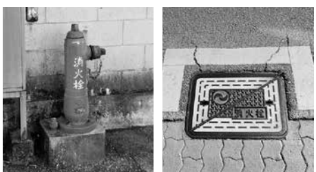
左：地上式消火栓、右：地下式消火栓
