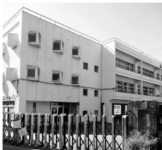
建て替えが予定される松田小学校
