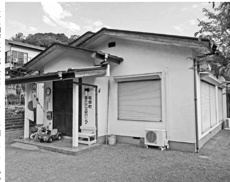
屋根等を改修する湯の沢児童センター
