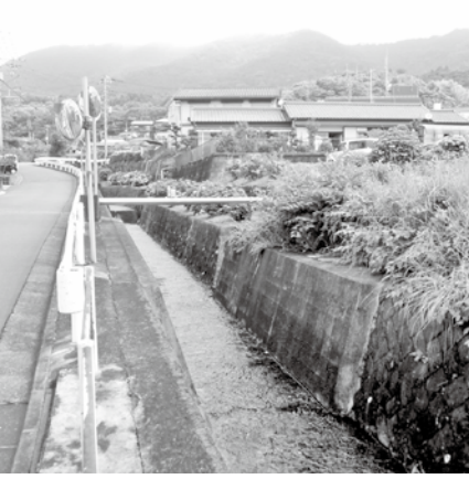
家ノ河原線橋梁予定地
