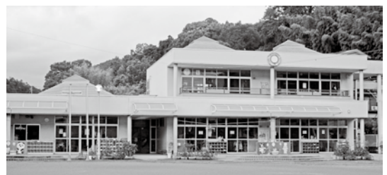
松田幼稚園園舎
