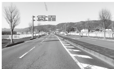
酒匂川左岸道路
