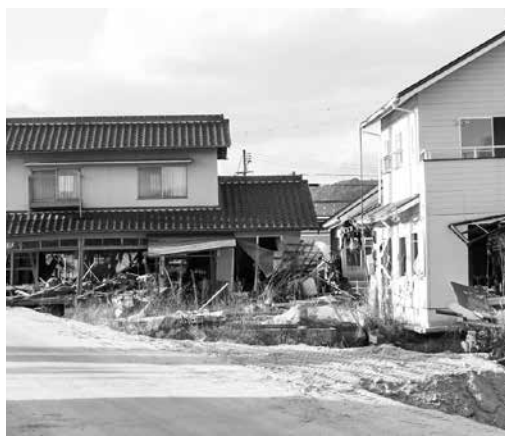
未だ傷跡の残っている被災現場
