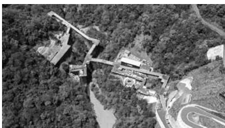
高松トンネル東坑口(右上方向:県道710号)
