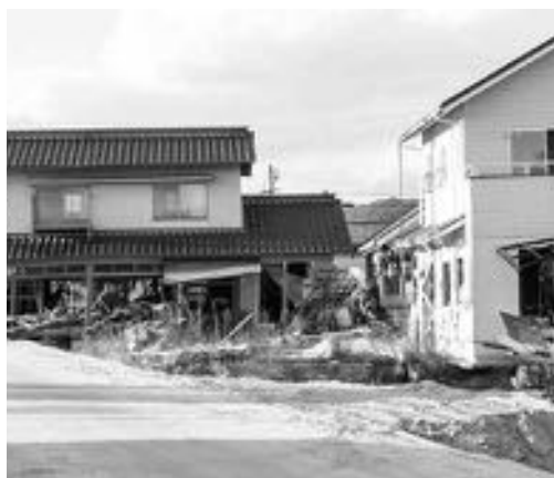
未だ傷跡が残っている被災現場
