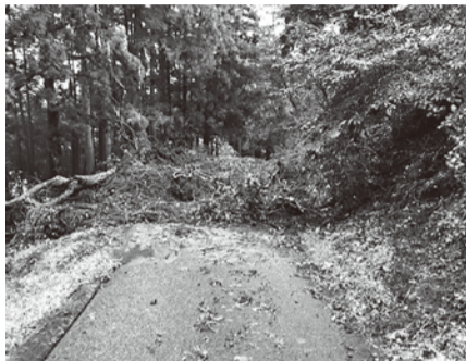
令和元年台風19号の際の土砂崩れ
