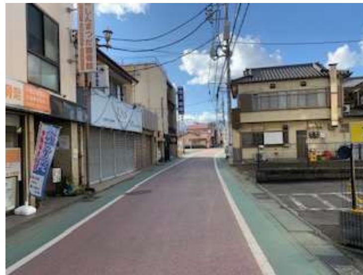
【町道3号線（ロマンス通り）】
